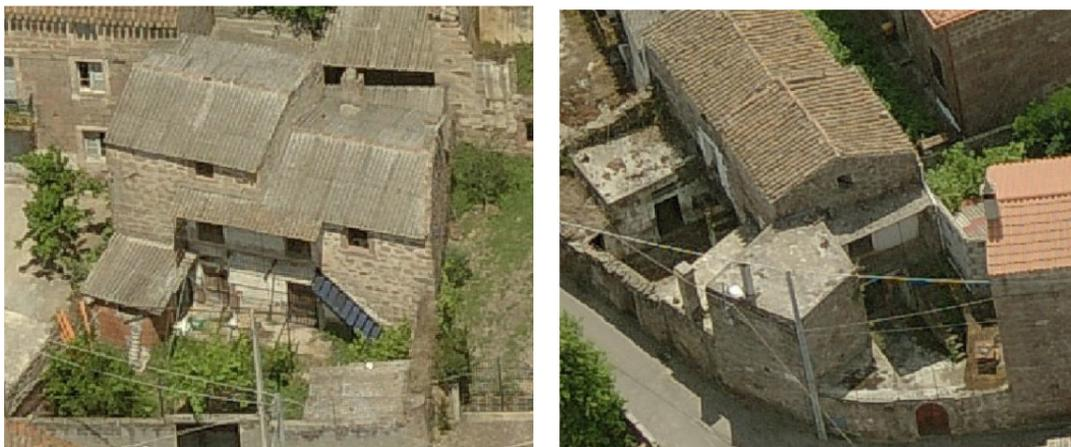
Scale esterne con struttura architravata e parapetto in ferro o in listelli lignei
