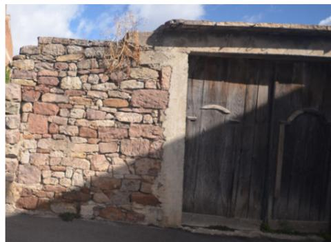
Muratura con conci di trachite rossa grossonamente sbozzati, apparecchiati con allettamento in terra e rinzeppatura, secondo corsi sub-orizzontali
