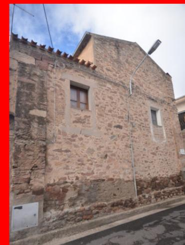
**Muratura con conci di trachite rossa grossolanamente sbazzati, apparecchiati con allettamento in terra e rinzeppatura, secondo corsi sub-orizzontali**
