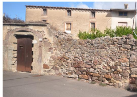
Muratura con trovanti di trachite rossa di differenti dimensioni apparecchiati con allettamento in terra e rinzeppatura, secondo corsi occasionali
