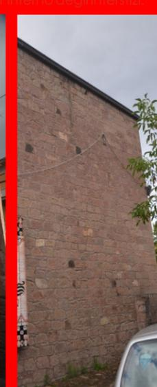
**Muratura ad «Opera pseudo-isodoma» con cantoni di trachite rossa squadrate, apparecchiati con allettamento in terra o mediante legante a base di calce**
