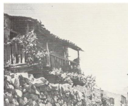
Nel nucleo storico di Samugheo sono tuttora diffusi i balconi in cosiddetto "stile barbaricino" (cfr. Vico Mossa in "Architettura domestica in Sardegna"), costituiti da una struttura composta da travetti a sbalzo, impalcato in tavole e parapetto, tutto in legno e pensilina di coperturan in coppi su impalcato ligneo sorretto da dei puntoni anch'essi lignei
