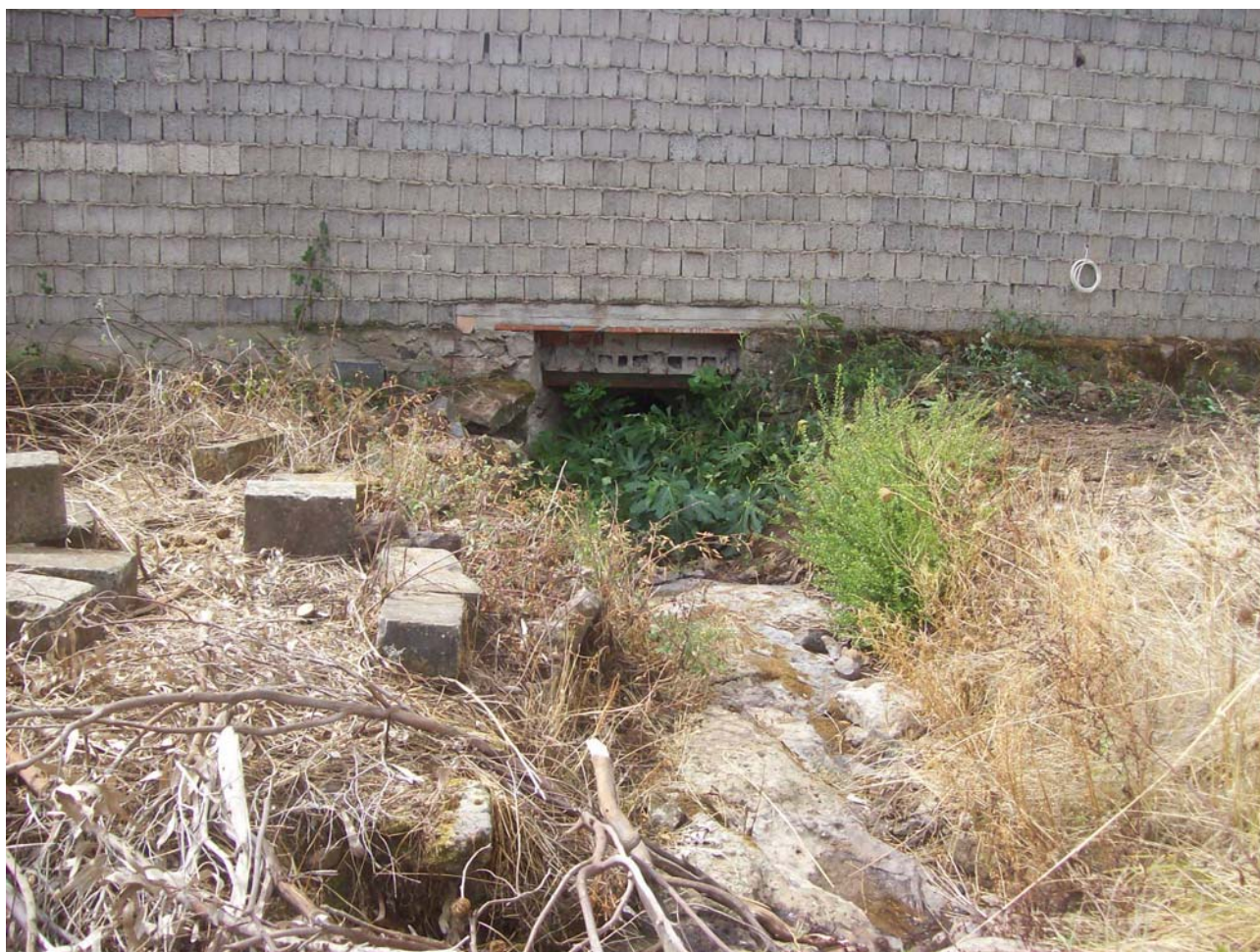
Illustrazione 3: Rio Garzarais – imboccatura condotta in prossimità della rivendita di materiali edili
